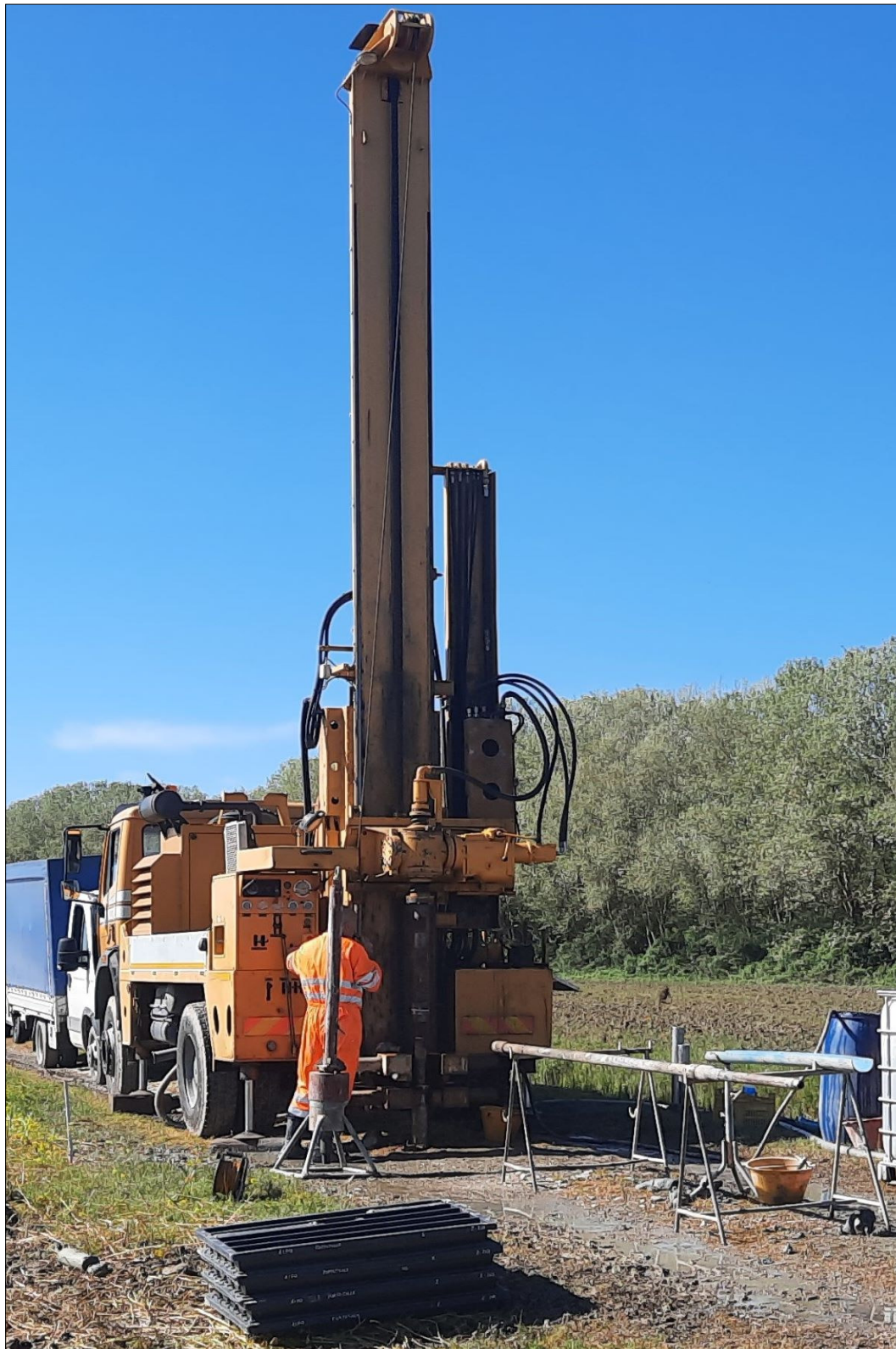
Piazzamento perforatrice su punto di sondaggio S2-2023
