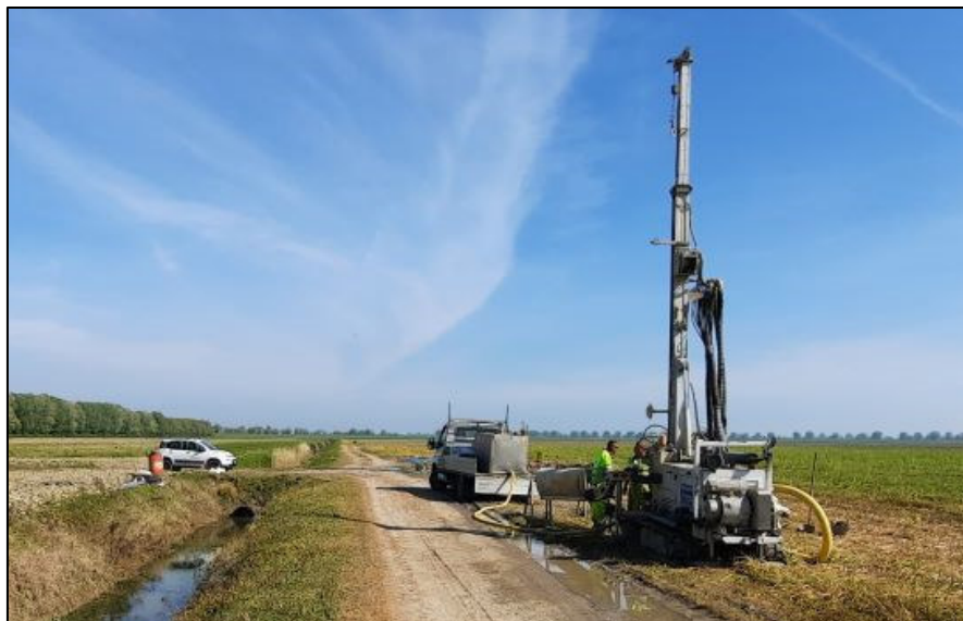
Figura 3.3. Perforatrice idraulica FRASTE utilizzata.
