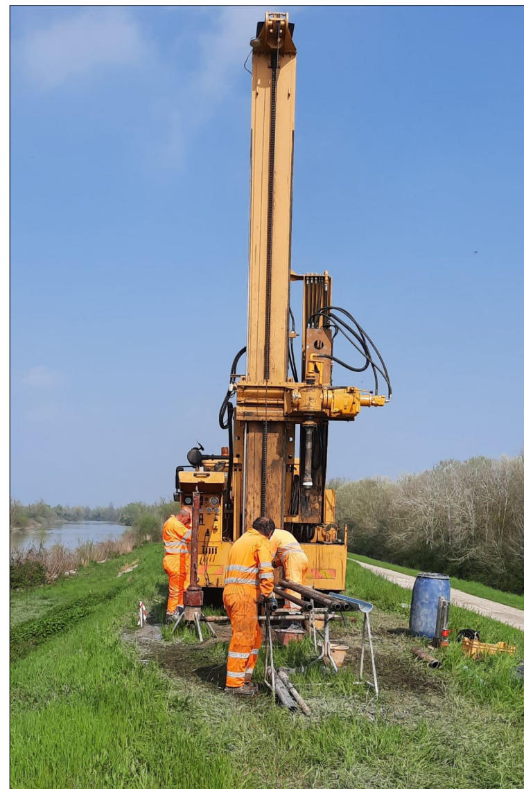
Piazzamento perforatrice su punto di sondaggio S3-2023
