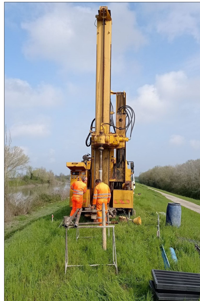
Piazzamento perforatrice su punto di sondaggio S1_2023
